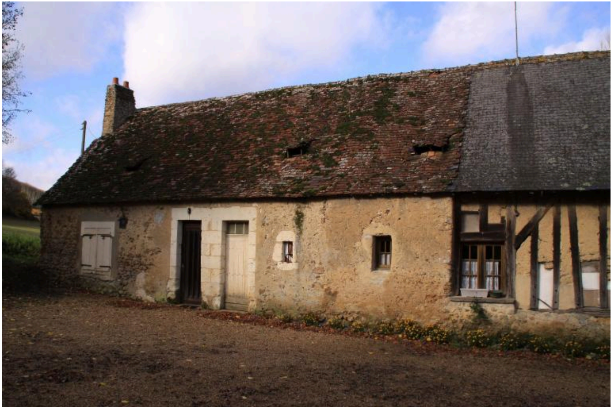
Maison 2 en maçonnerie.
