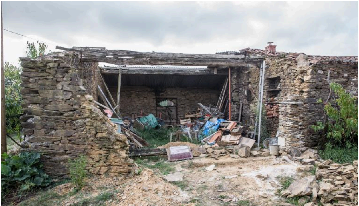
Habitation en rez-de-chaussée à une pièce sous charpente. Cadastre 2018, B 01-278.
