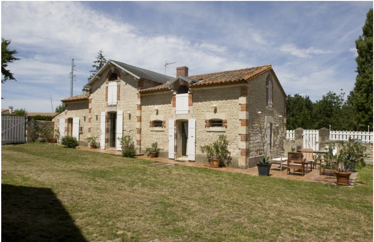
Vue du bâtiment nord (laiterie, boulangerie, chambre de domestique, toits à cochons, poulailler), prise du sud.
