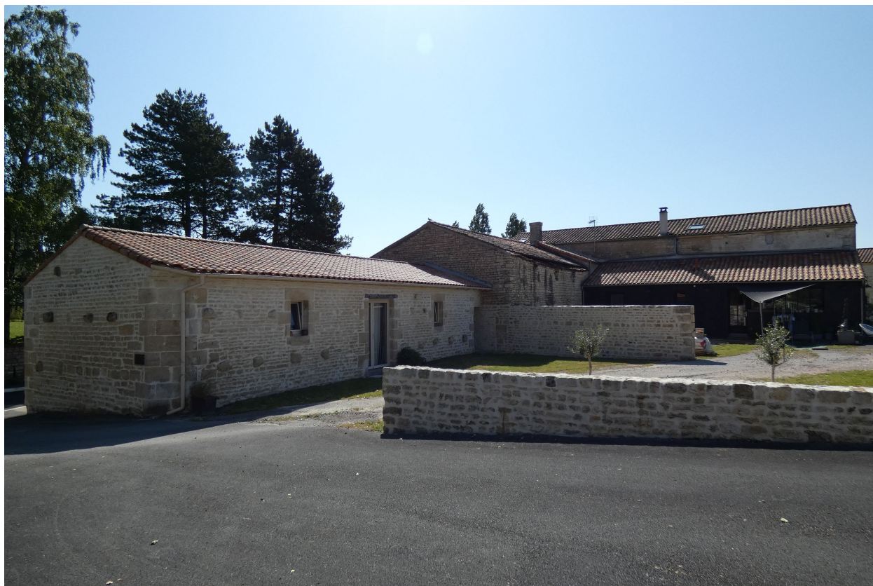
L'ancienne ferme vue depuis le nord-ouest.
