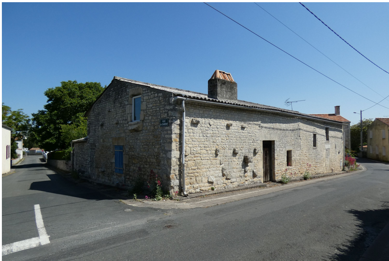
La dépendance vue depuis le sud-ouest.
