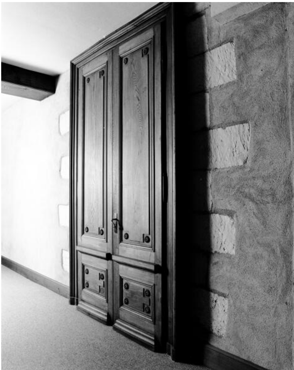
Partie sud de l'aile orientale, vestige du passage aménagé pour la préfecture entre cour et jardin (avant 1840) : porte ouest, élévation intérieure.
