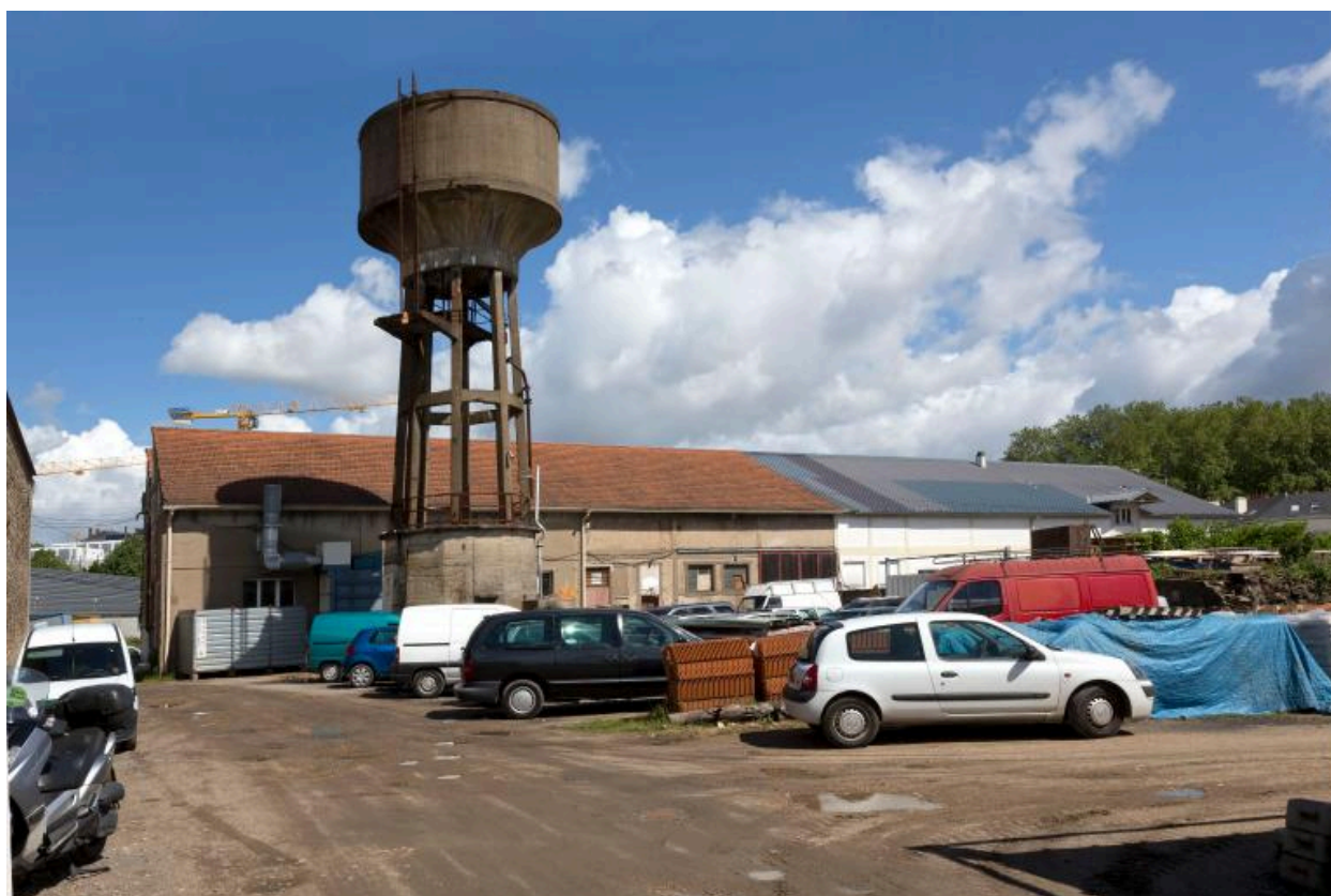
Sous-station électrique et château d'eau.
