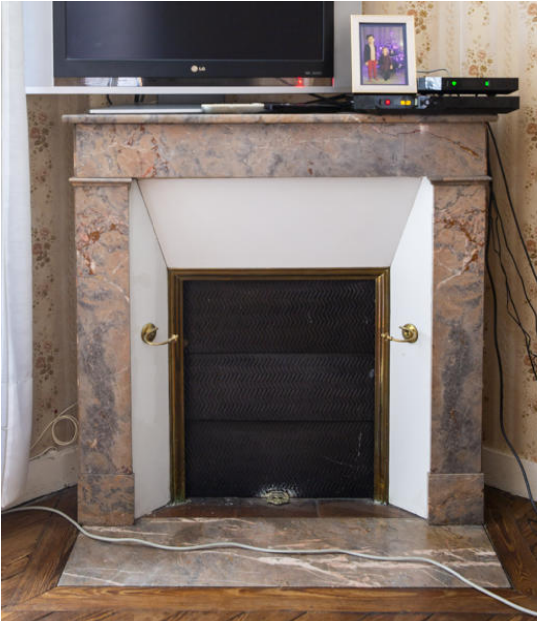
Vue de la cheminée du premier étage.
