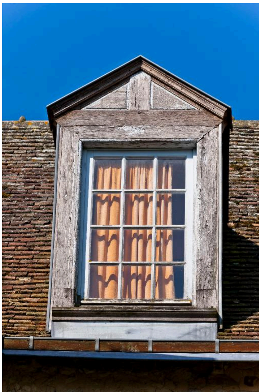
Lucarne de l'élévation sur cour du logis, portant la date 1784.
