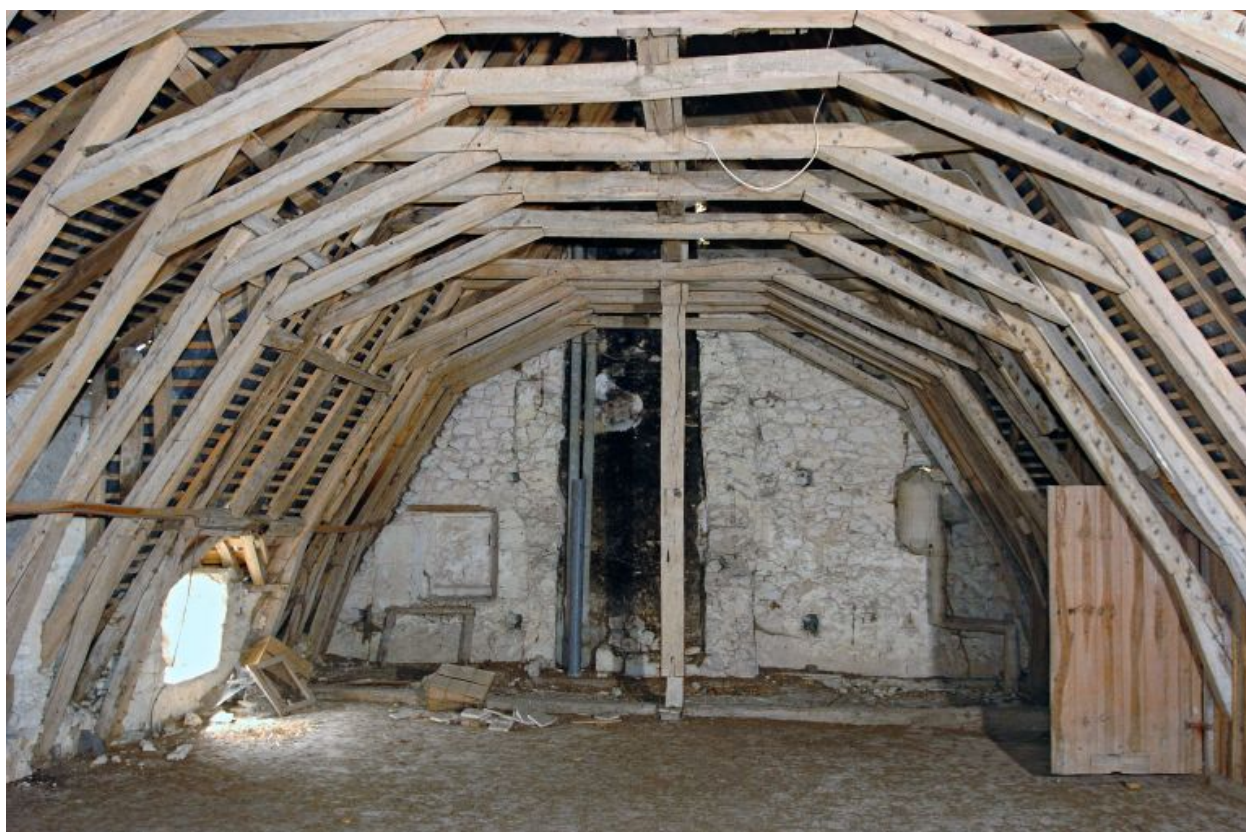
Le logis, aile ouest : charpente à chevron-portant-ferme.
