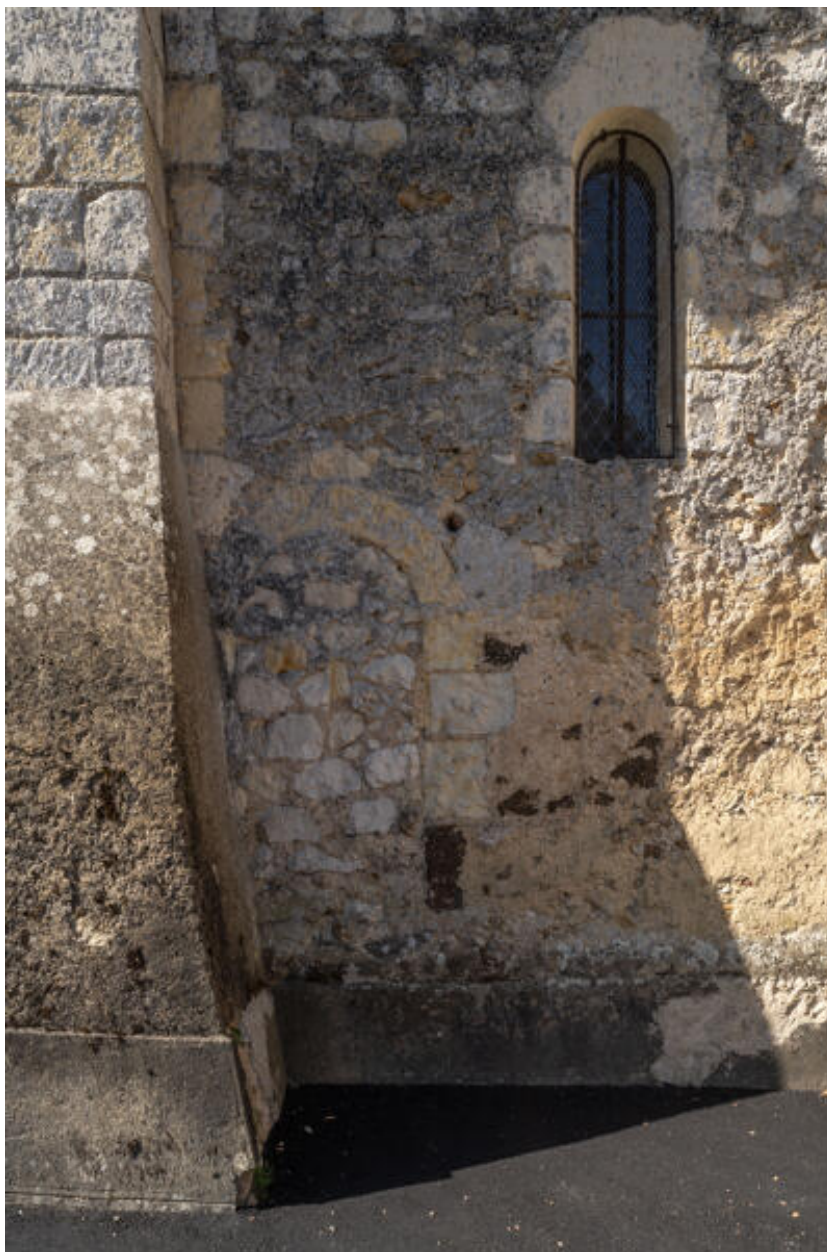
Mur extérieur du choeur, côté nord : porte bouchée et baie romane.
