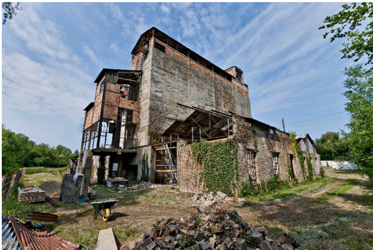
Atelier de blutage et silos de stockage, façades sud-est.
