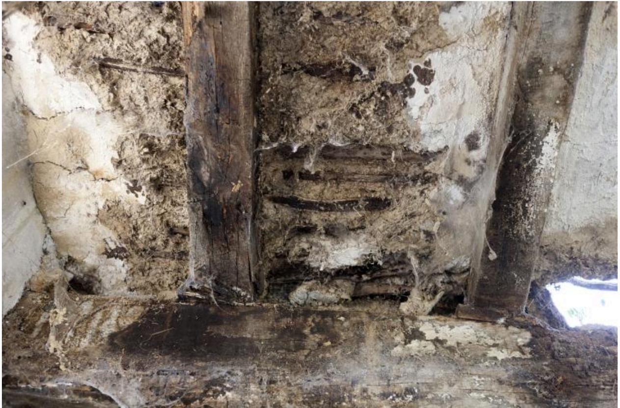
Bogat, détail du système de construction du plancher du comble posé sur le solivage de la salle.
