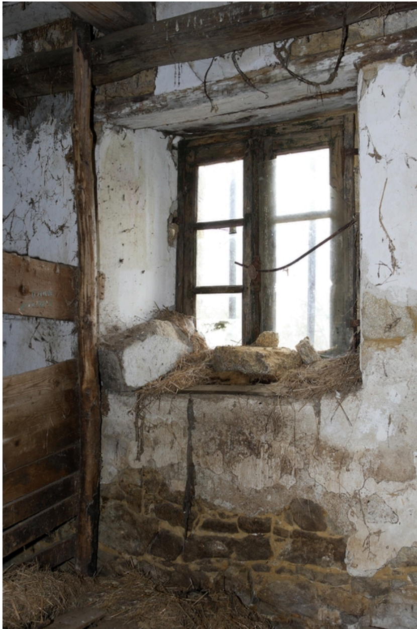
Détail de l'intérieur de la fenêtre du 1er logis.
