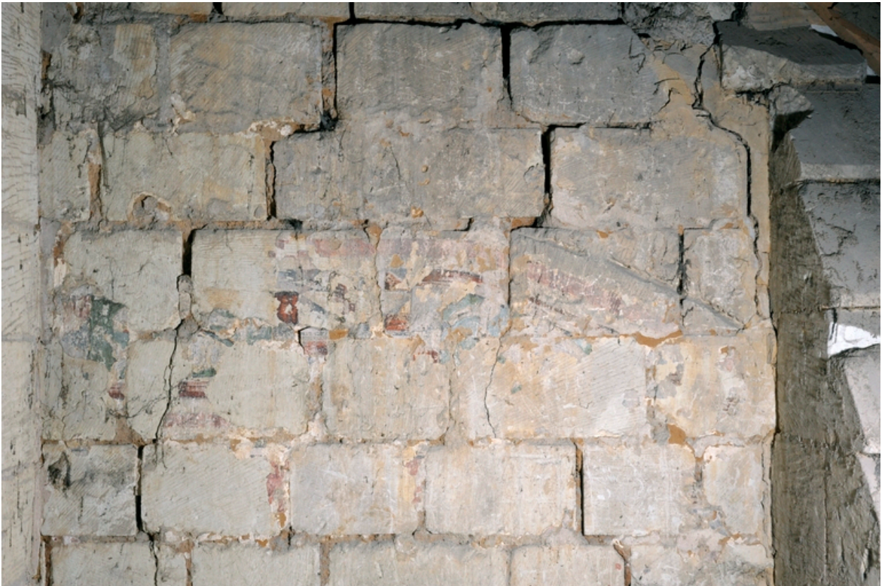
Comble, mur nord (correspondant à la face extérieure du mur de la nef de l'église Saint-Michel). Vestige d'une peinture murale médiévale.
