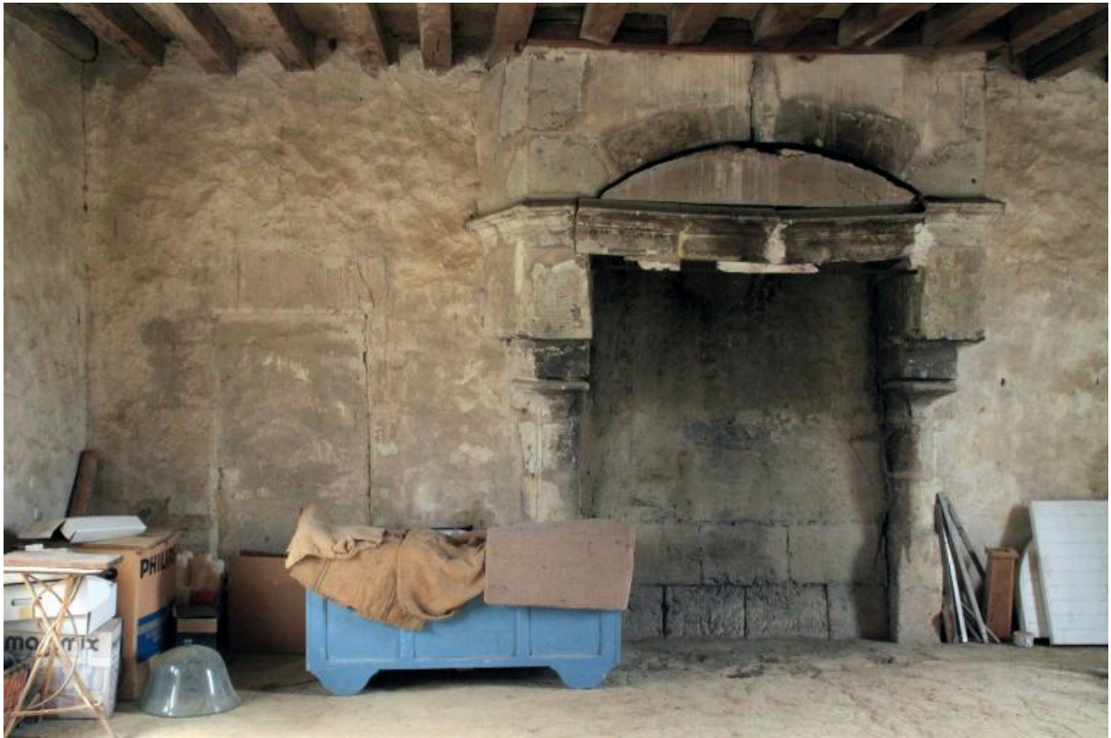
La grande salle du premier étage : cheminée du pignon nord.
