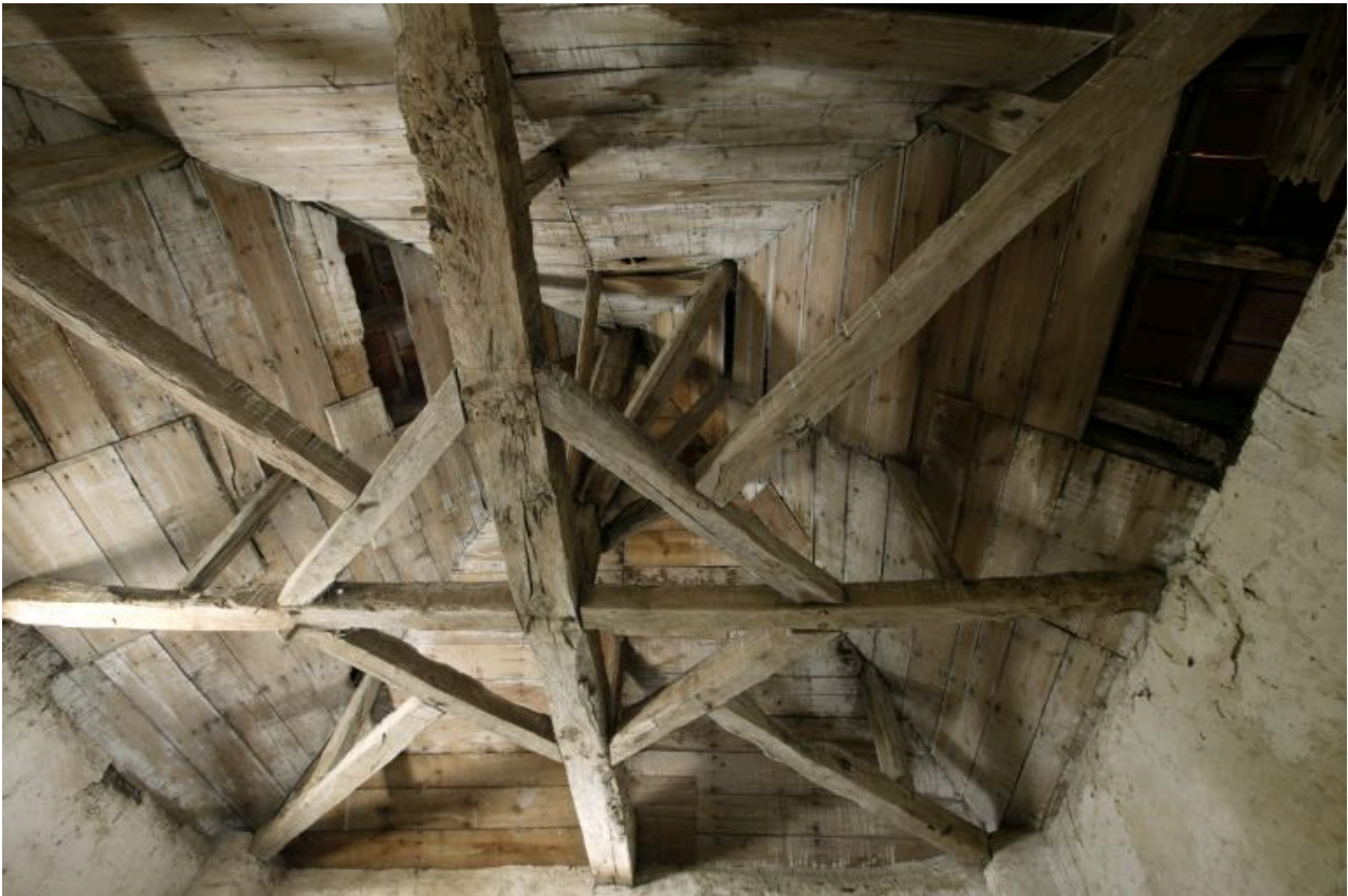
Vue de la charpente à enrayure.
