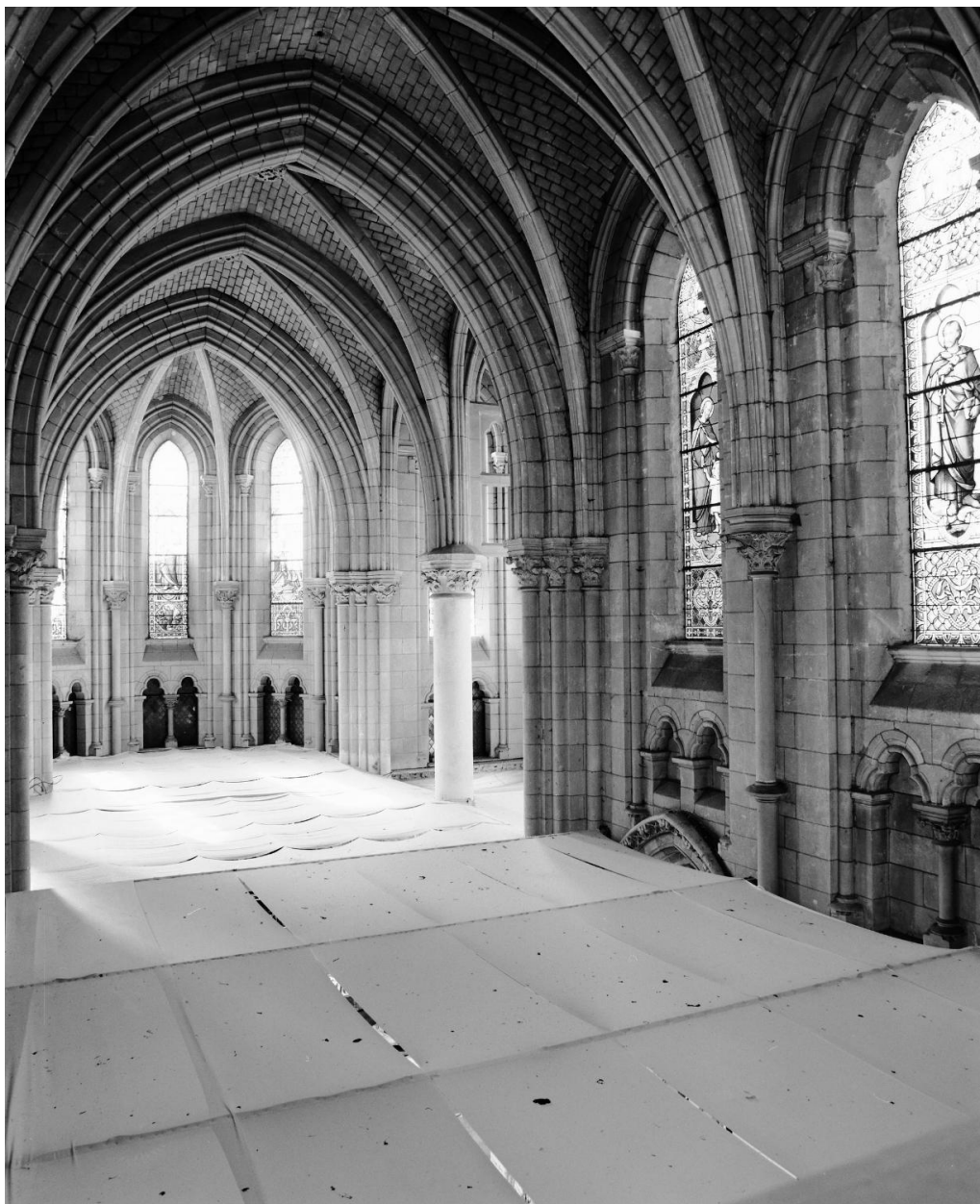
Eglise : vue d'ensemble vers le chœur et le bras sud du transept, depuis la tribune de la nef.
