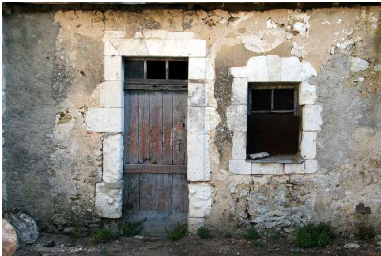
La maison 9 : porte rehaussée et fenêtre.
