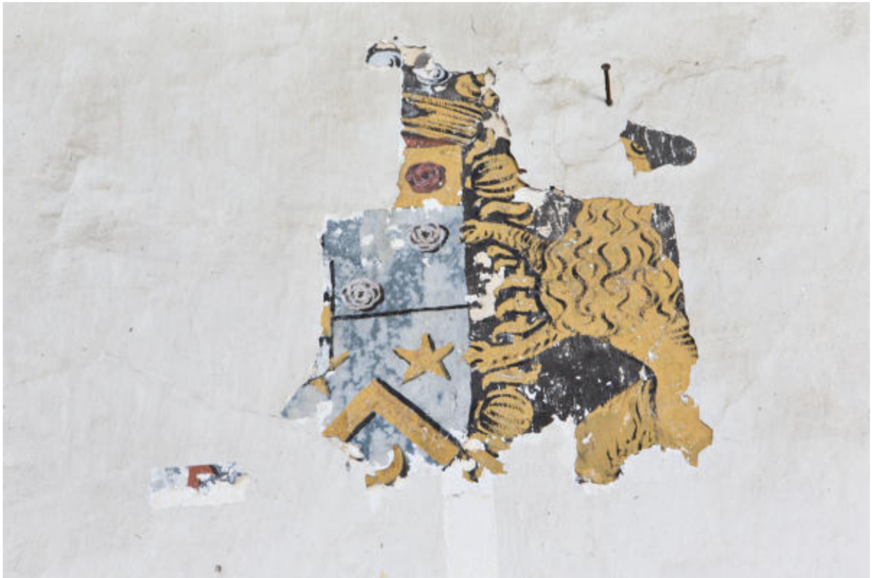
Intérieur, nef, mur sud, fragment de peinture monumentale : armoiries.
