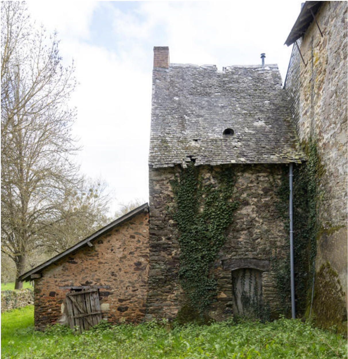
Le bâtiment abritant le four.
