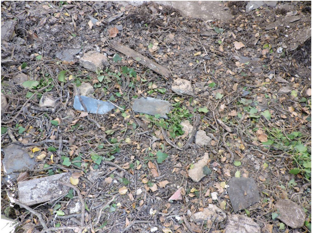
Vestiges d'ardoises au sol de l'étage de soubassement.
