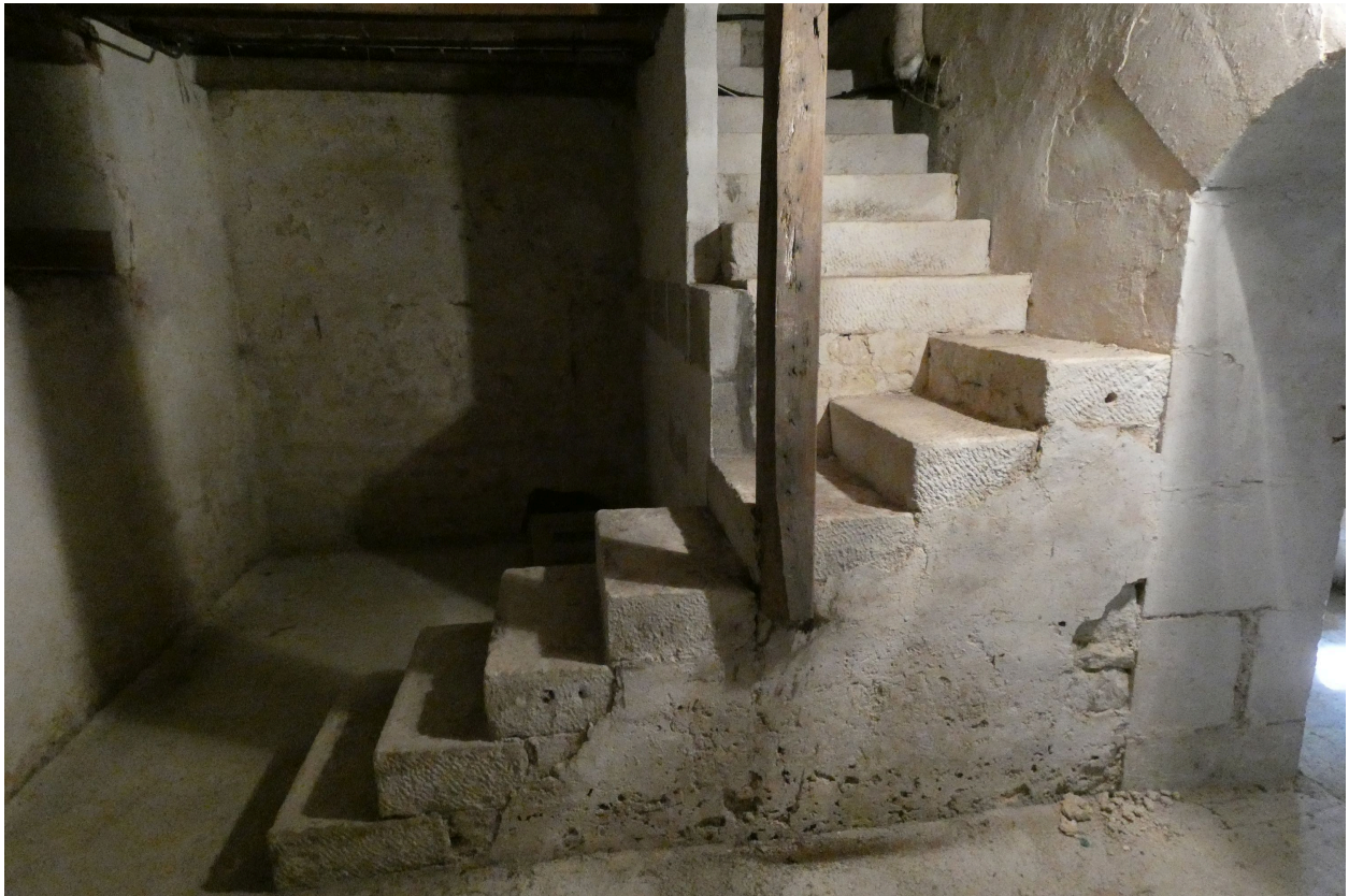
Escalier en pierre descendant au sous-sol.
