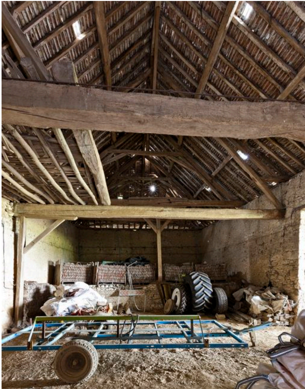
Vue intérieure de la partie gauche de la grange-étable-fenil
