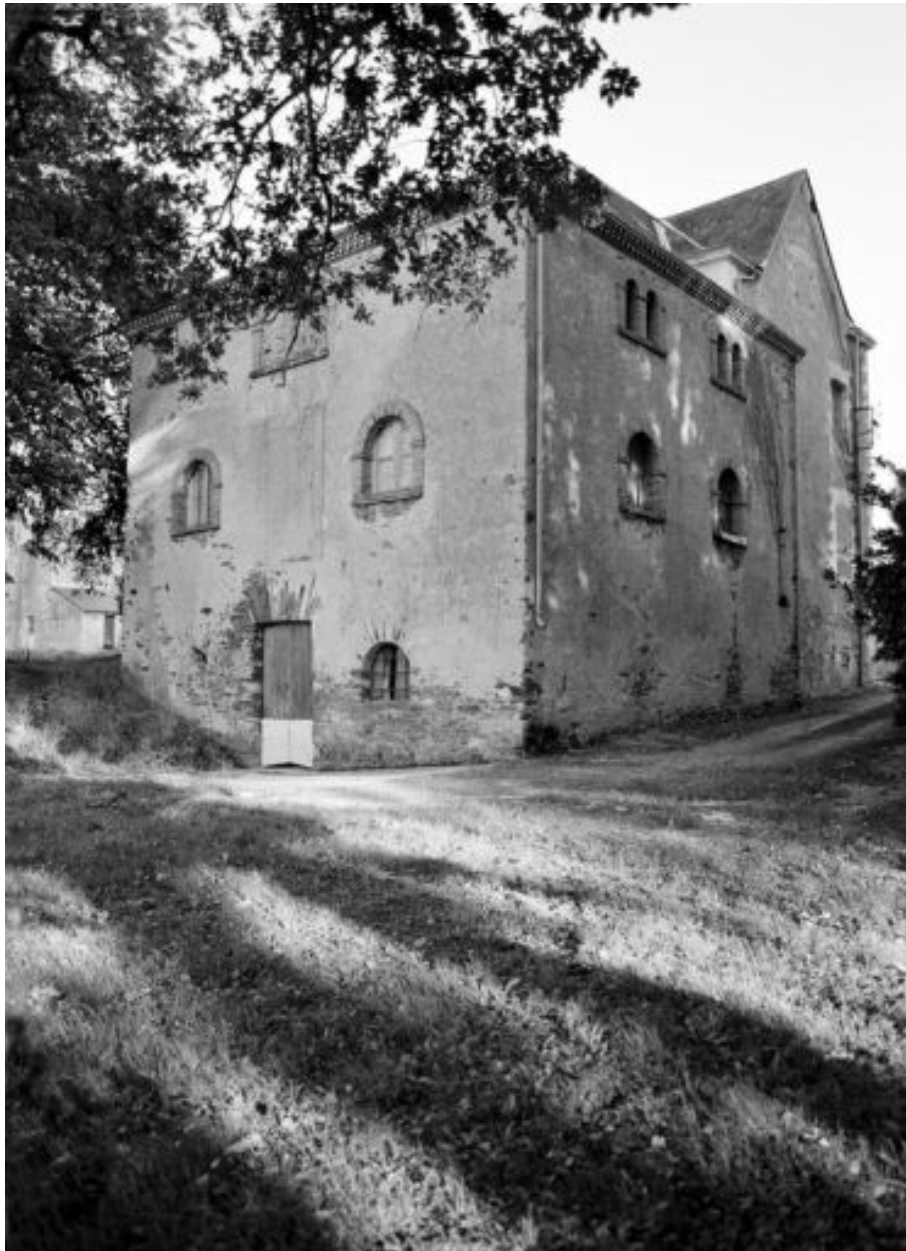
La grange : détail des ouvertures et porte fanière murée.
