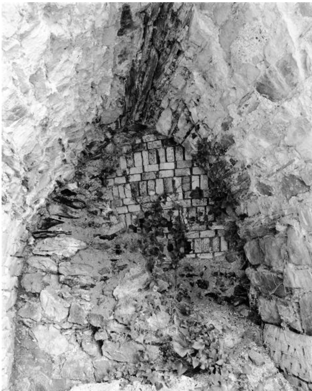
Robe du four obstruant la porte de défournement de l'ébraisoir sud-est, massif du four, partie est, fours de la Tranchée, Montjean-sur-Loire.
