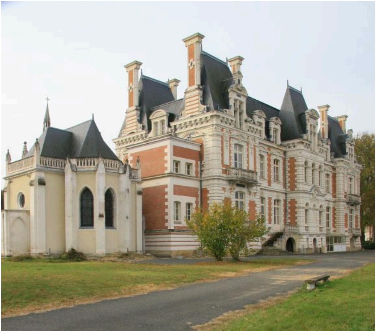
Vue de volume de la façade postérieure.
