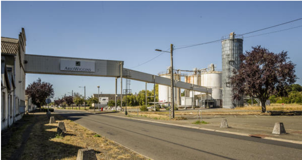
Vue d'ensemble depuis la rue, montrant les réservoirs de carbonate de calcium et la conduite alimentant l'atelier de couchage.
