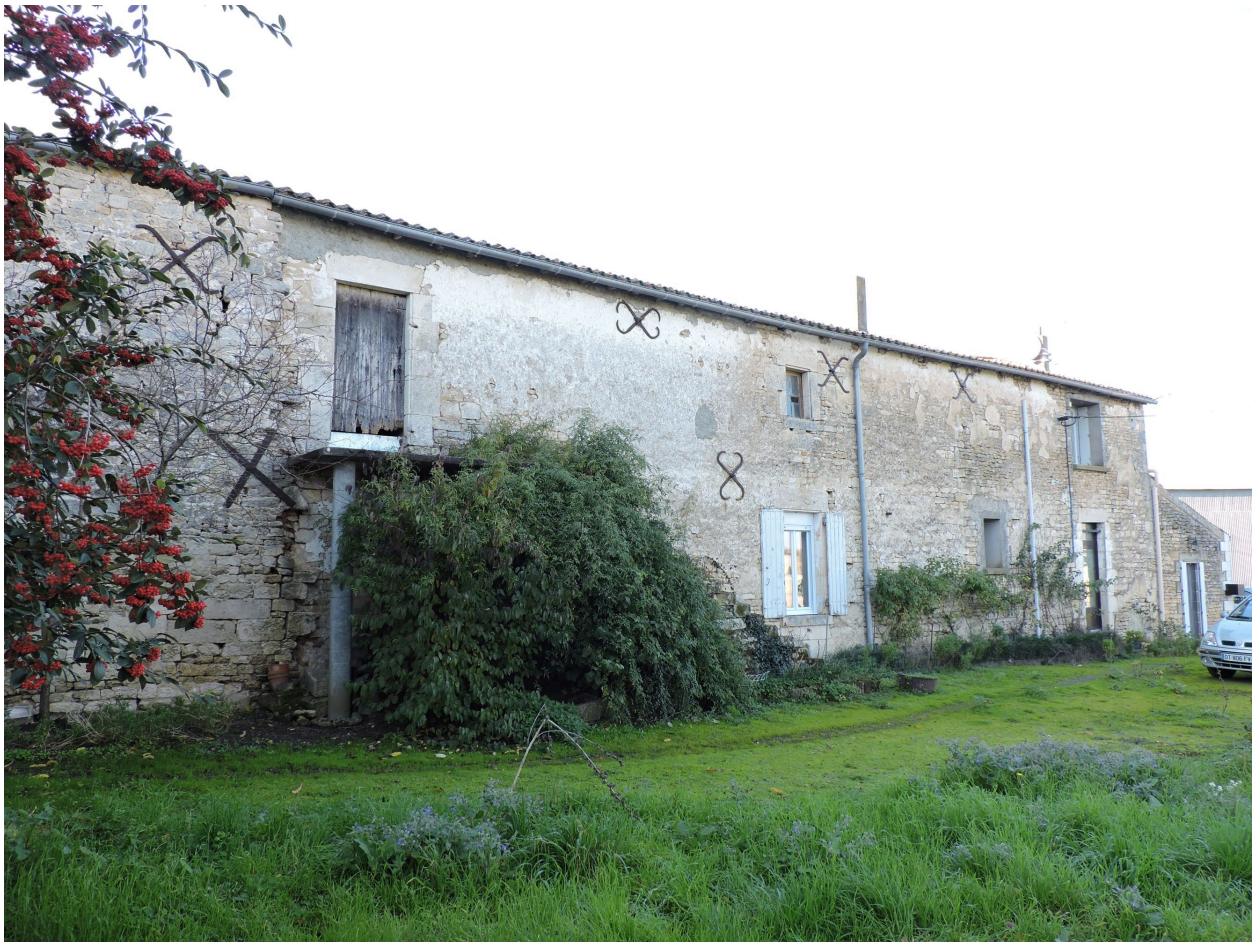
L'aile de communs vue depuis le sud-est.
