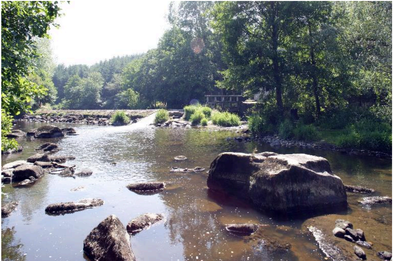
Le barrage vu depuis l'aval à l'ouest.
