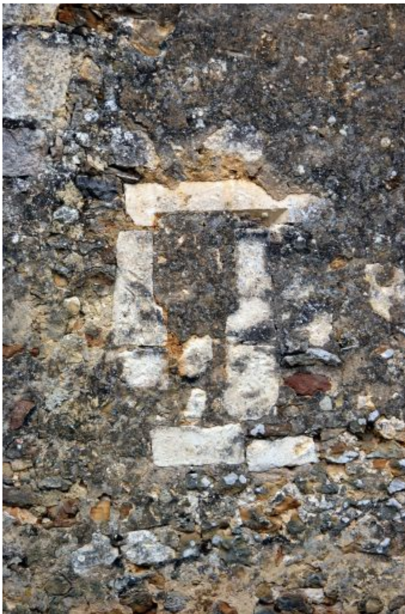
Maison de potier, pignon remanié.
