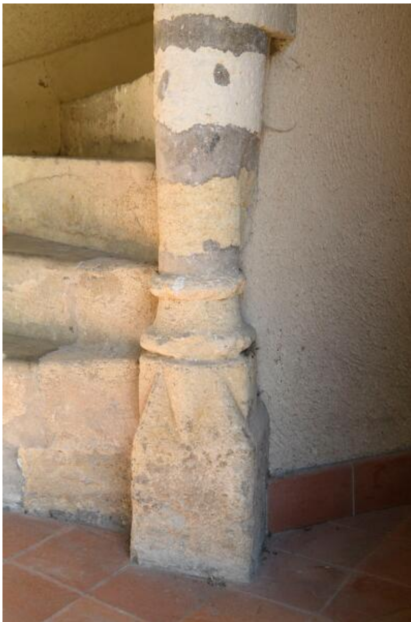
Détail de la base du noyau d'escalier.
