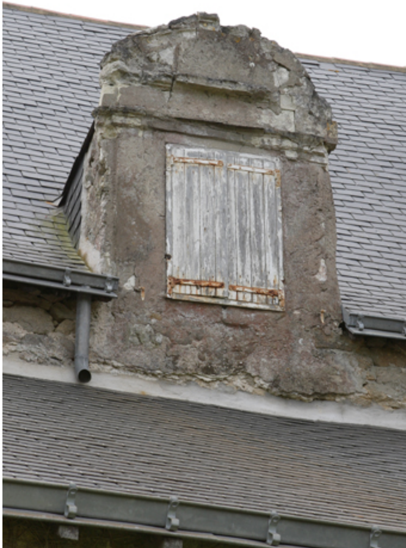
Logis. Façade postérieure. Détail de la lucarne de gauche.
