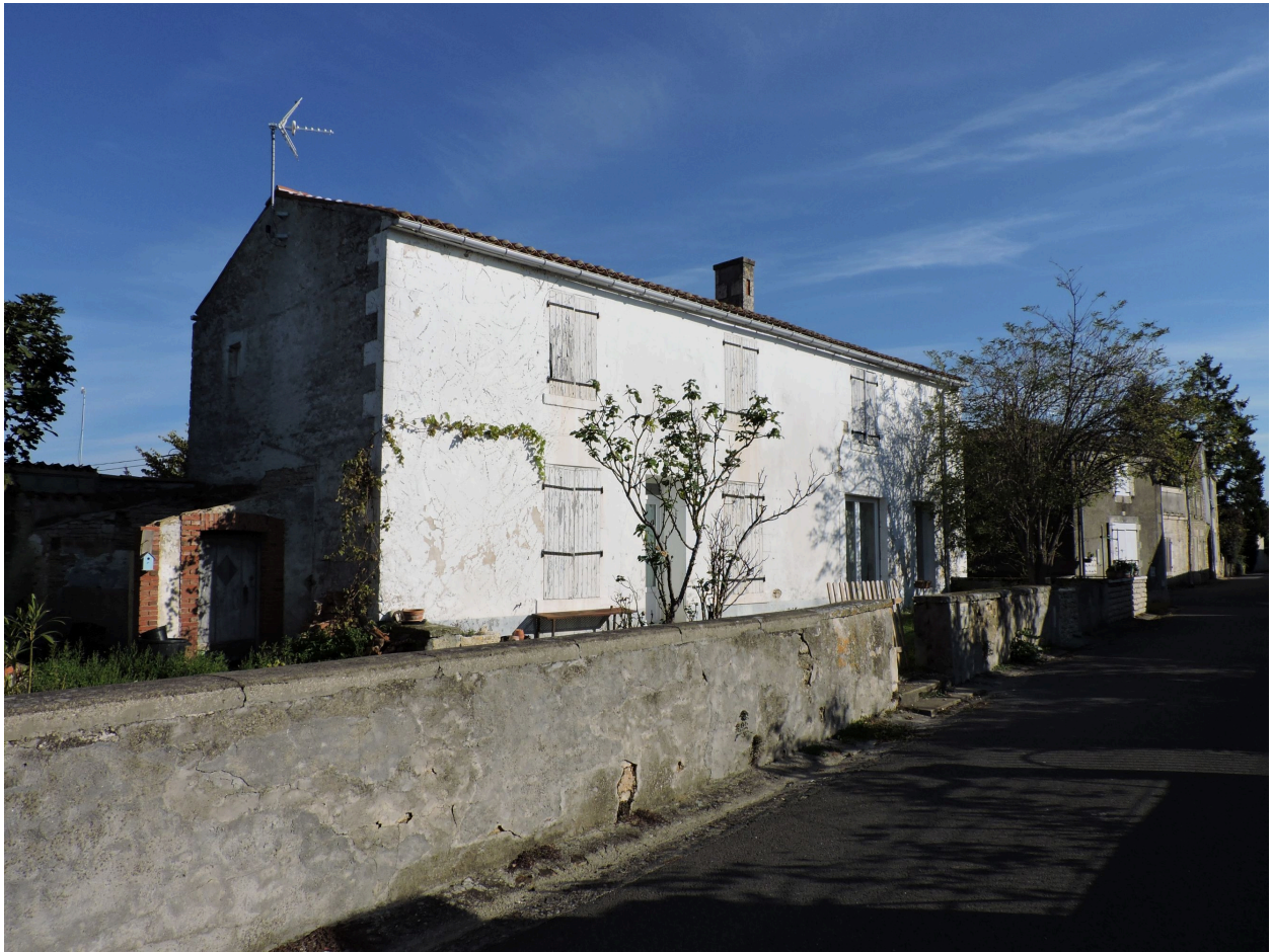
Vue depuis le sud-ouest.
