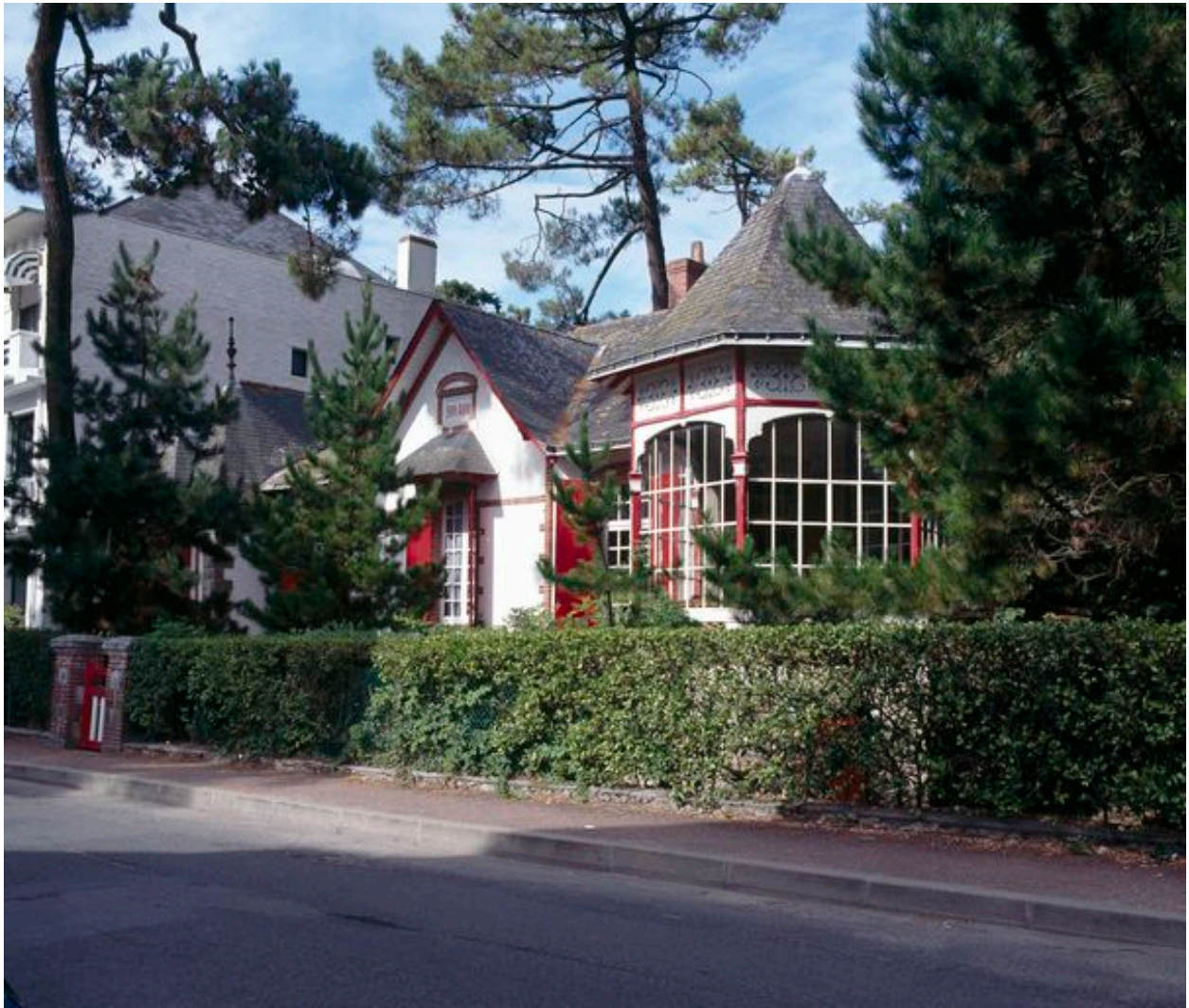
Façade avenue des Evens.
