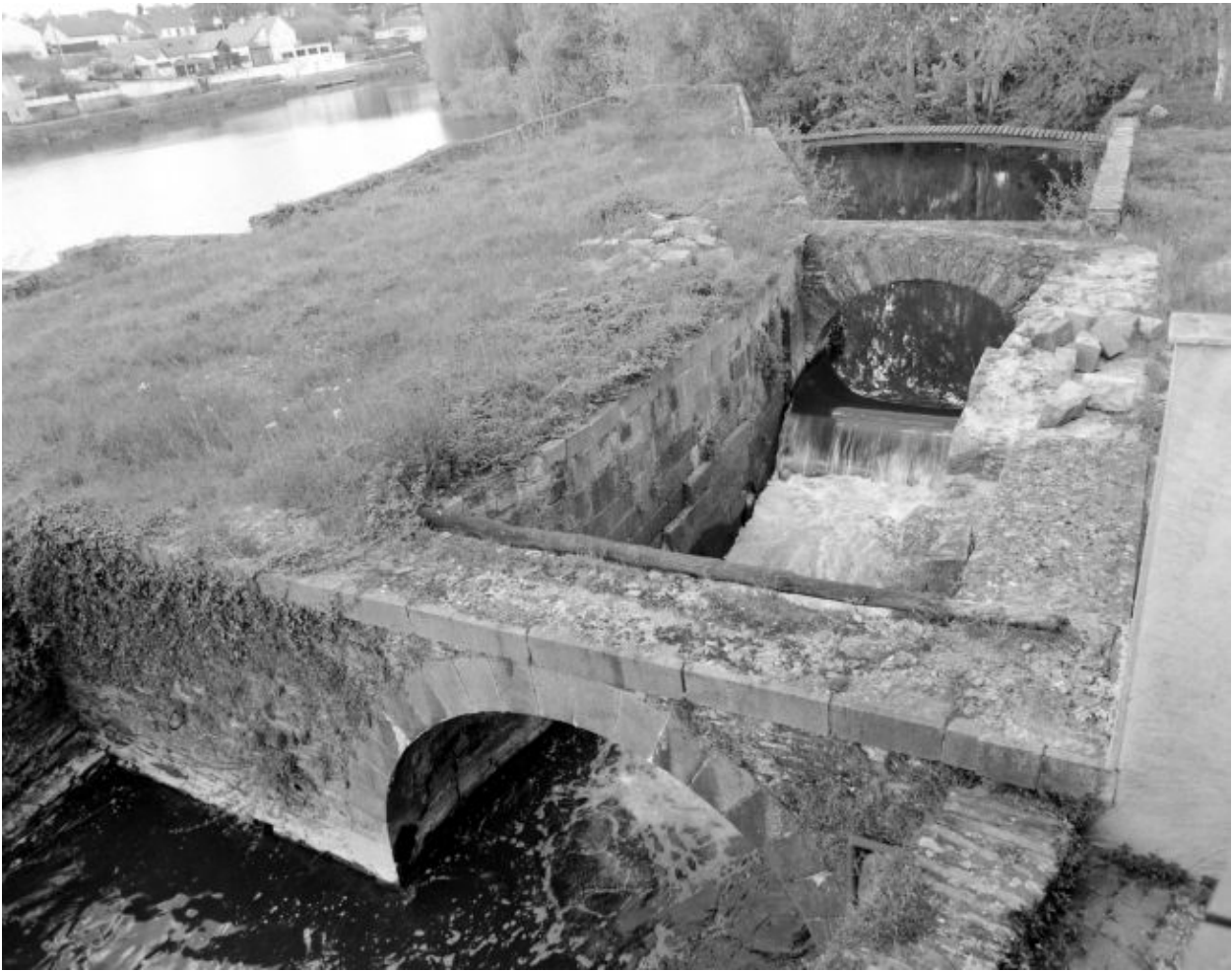
Vestiges du moulin : le coursier de rive vu d'aval.
