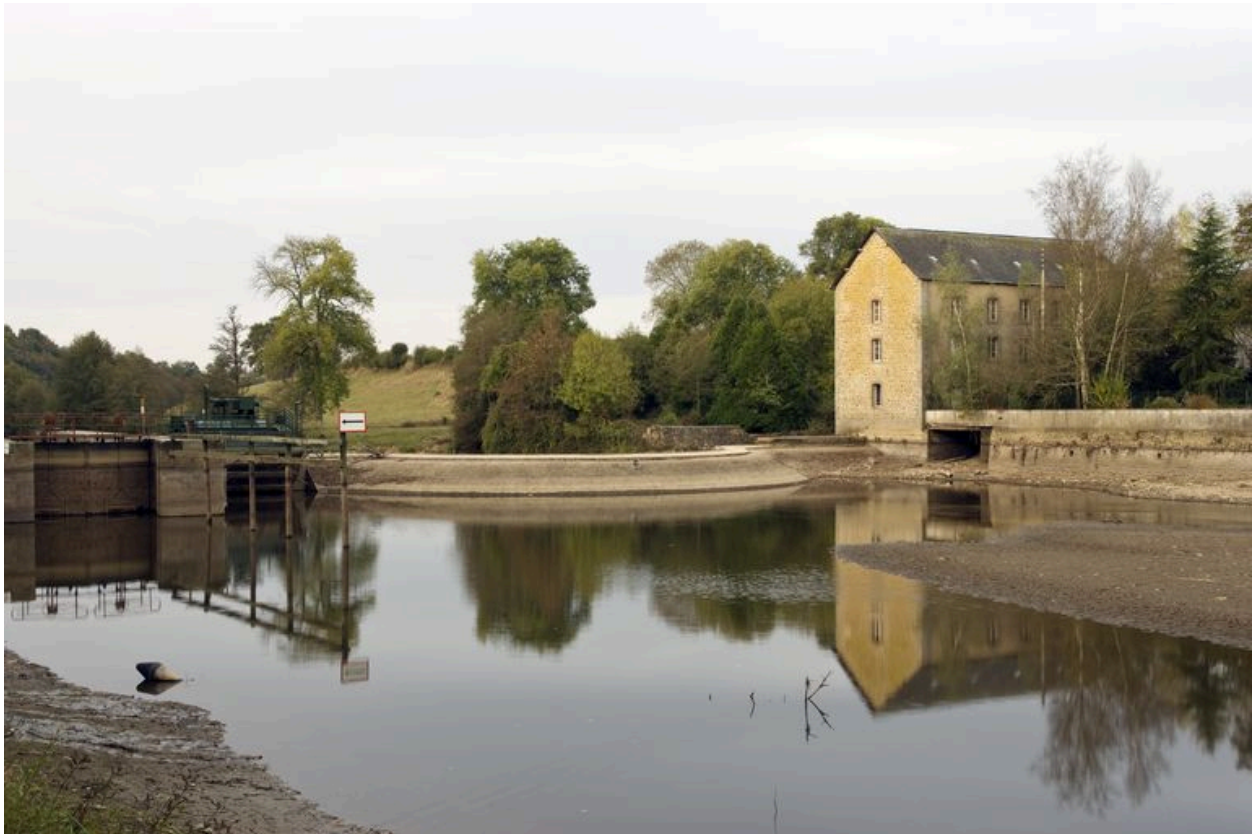
Vue d'ensemble depuis l'amont pendant les écourues de 2009 : écluse, pertuis, barrage, moulin.
