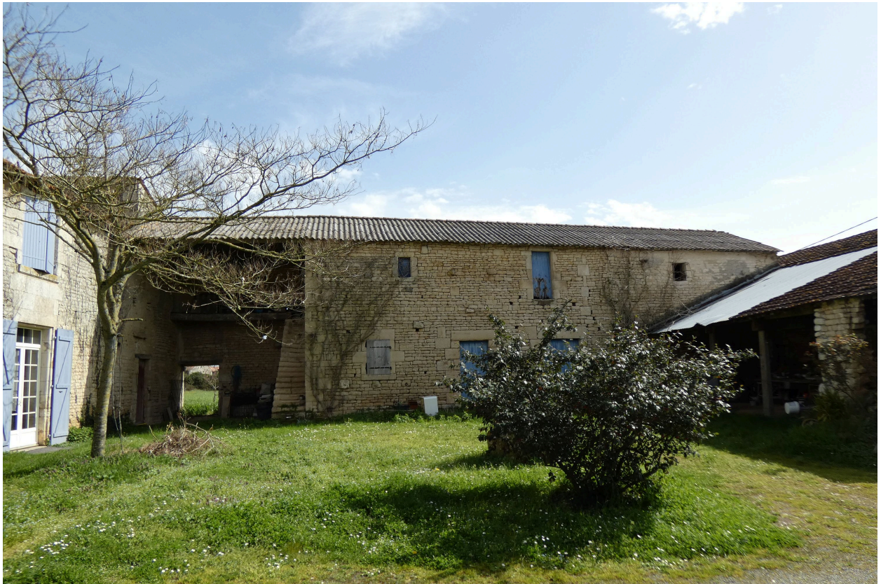
L'aile à l'est de la cour, vue depuis le nord-ouest.
