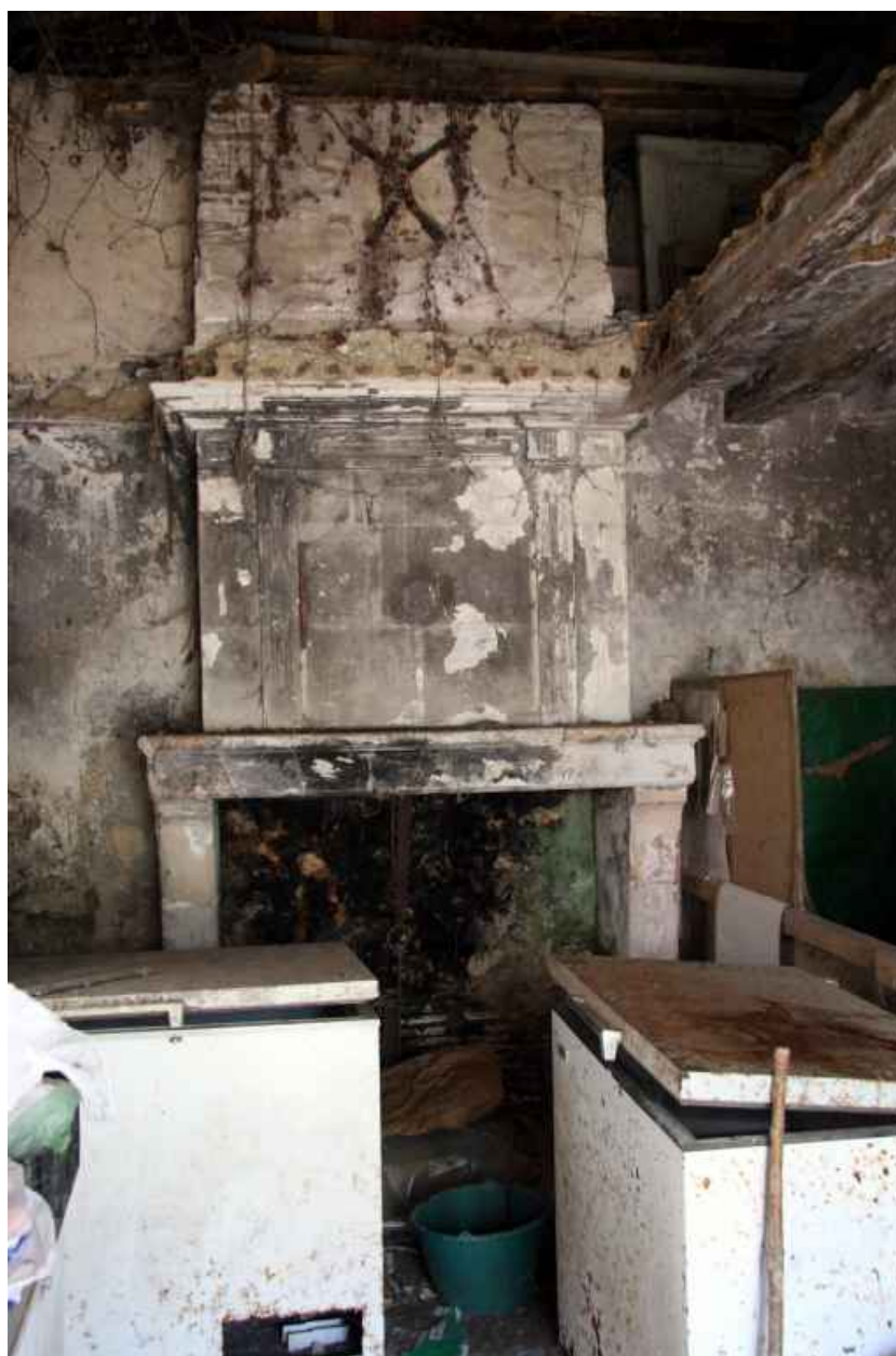
La maison 12 : cheminée XIXe siècle.
