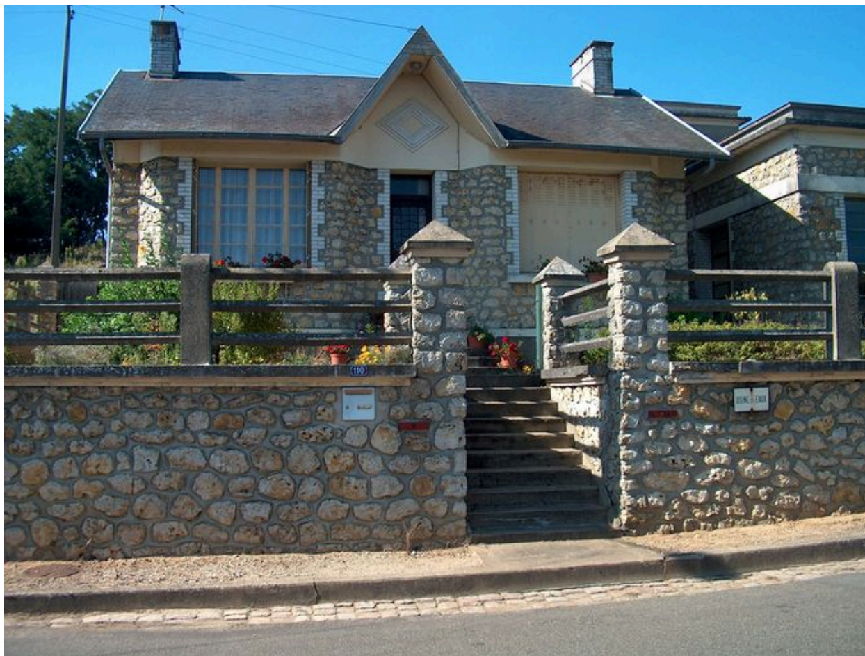
Élévation antérieure du logement.
