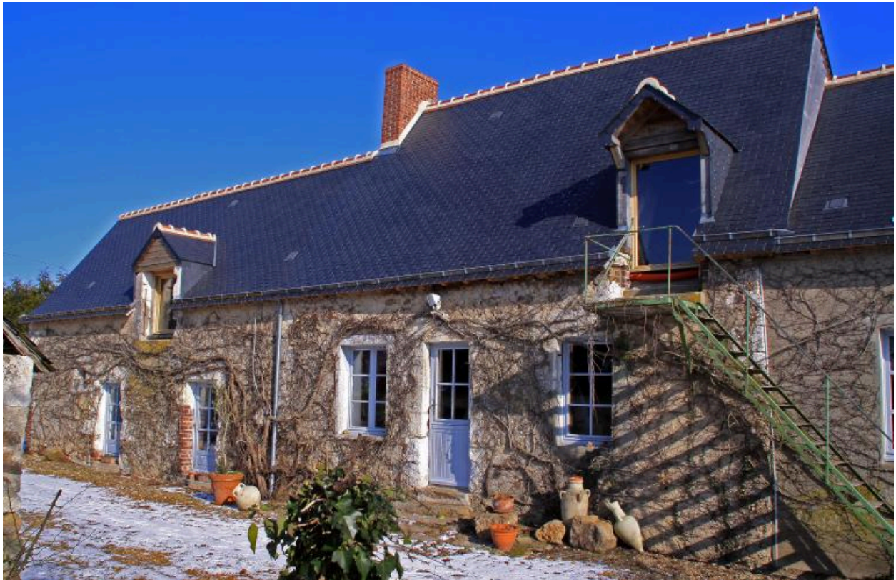
Vue d'ensemble, façade sur cour.
