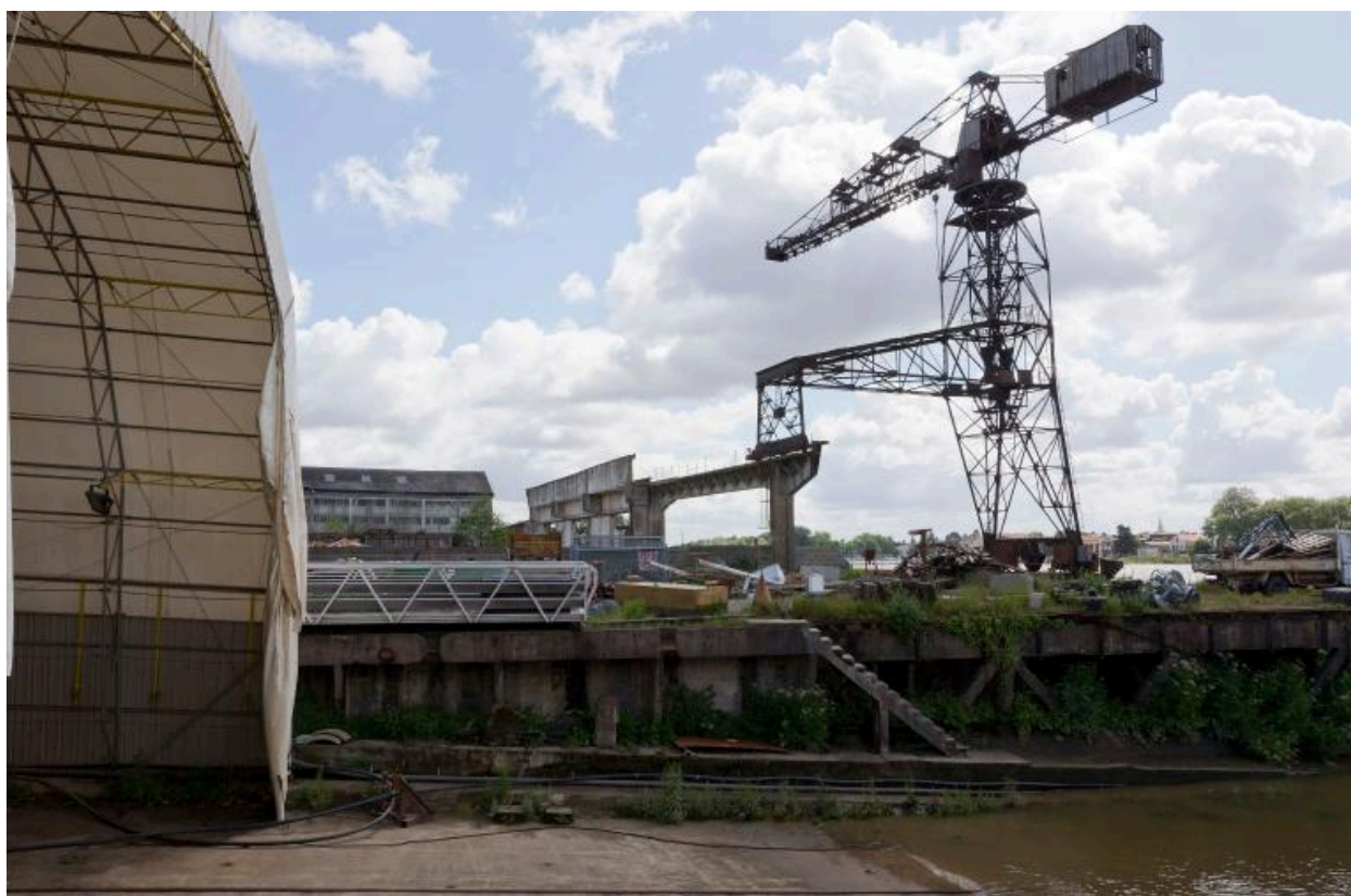
Grue appuyée sur le portique.
