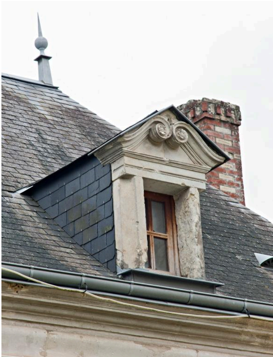
Façade ouest : lucarne de droite.
