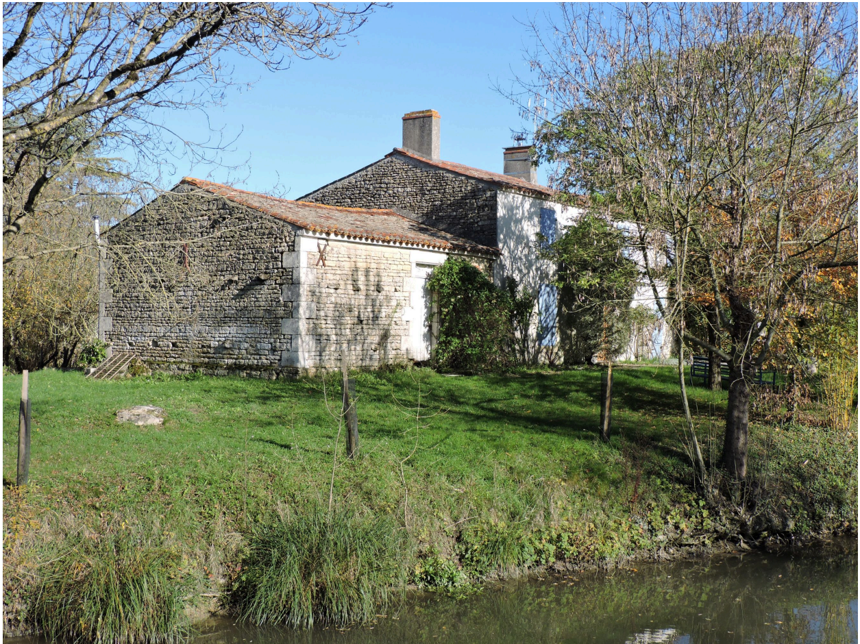
L'ancienne ferme vue depuis l'ouest.
