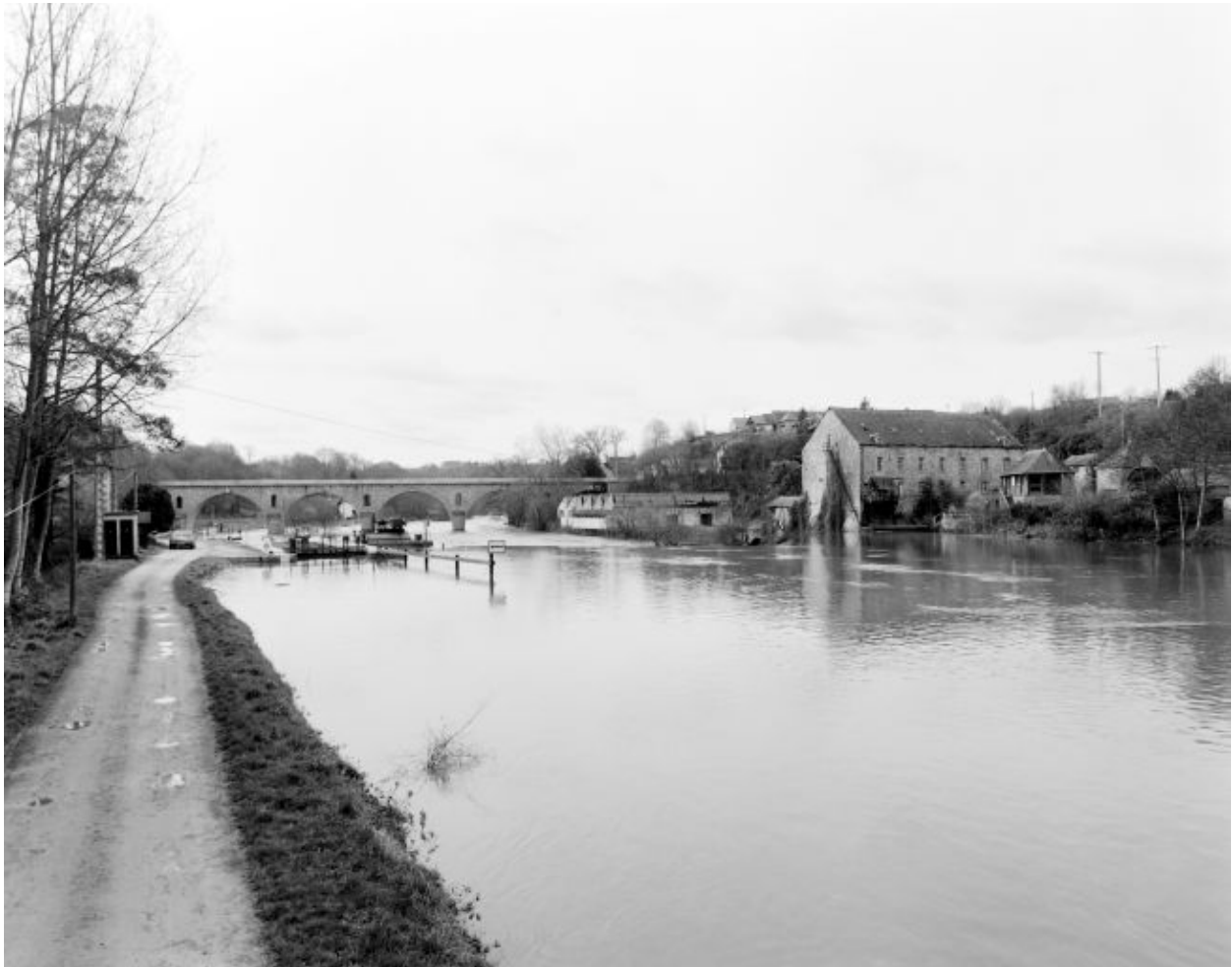
Vue d'ensemble du site depuis la rive gauche en amont : chemin de halage, écluse, ancienne usine d'amiante. Au fond, le pont de Rochefort.
