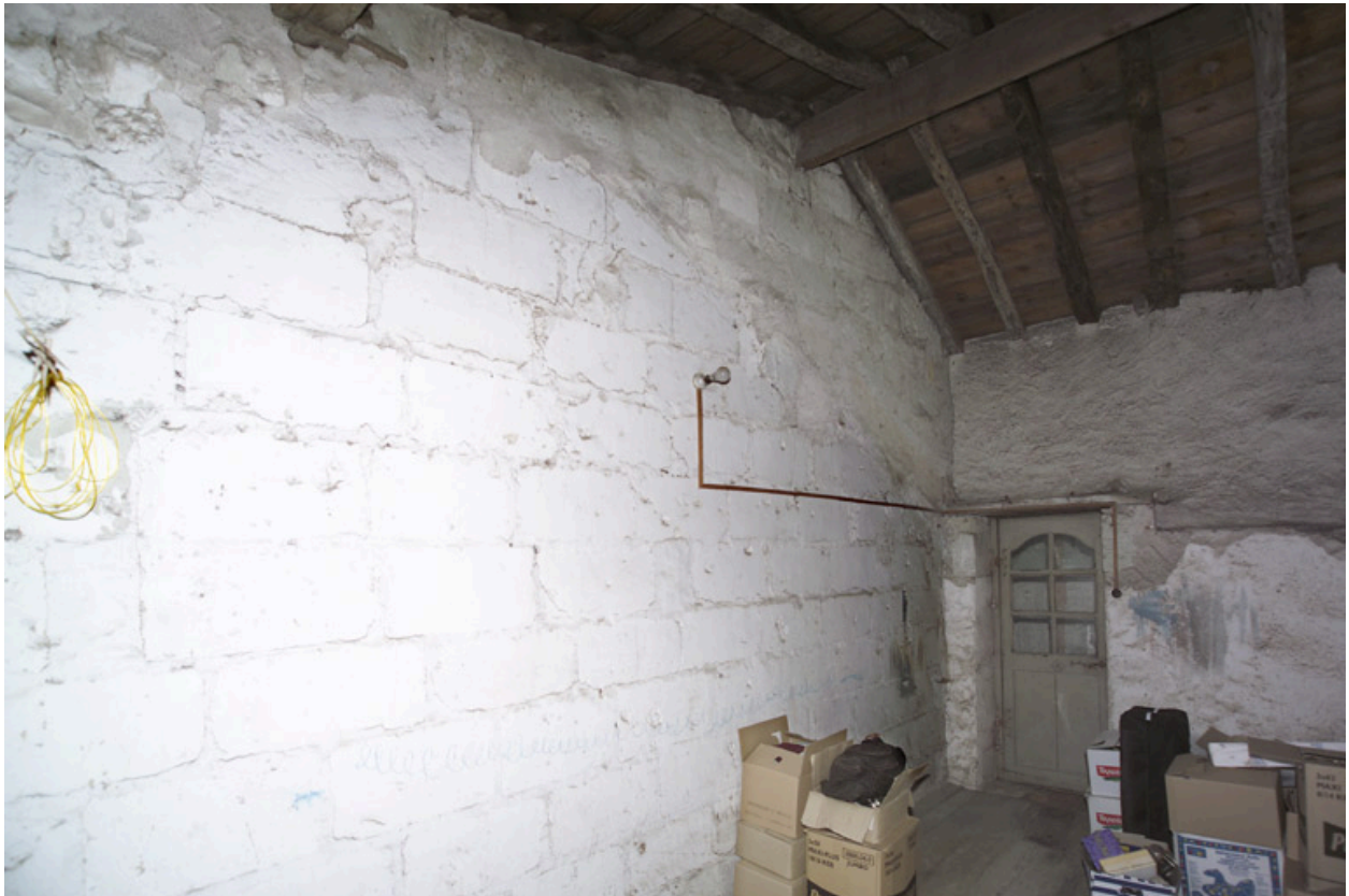
L'étage de comble vu depuis le nord vers le sud-est, à gauche le mur de refend.
