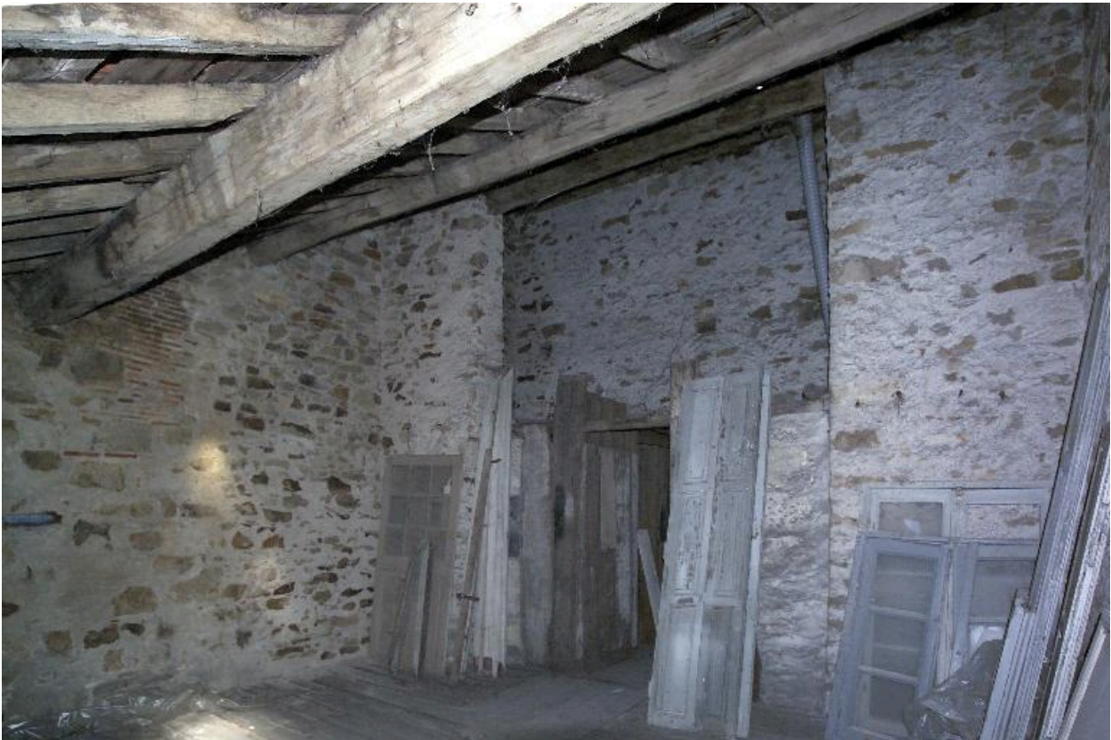
Le comble, vue prise de la façade sur la rue vers le mur de refend.
