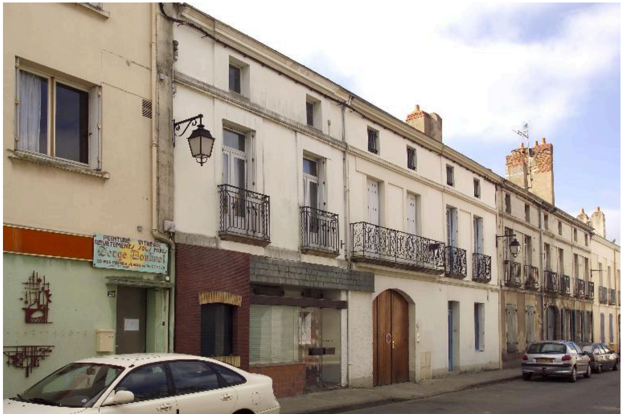
La maison n° 31 rue Pierre-Jubau.
