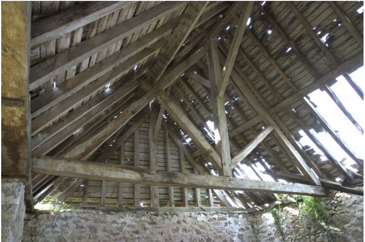
La charpente de la partie ouest de l'étable vue depuis l'est.
