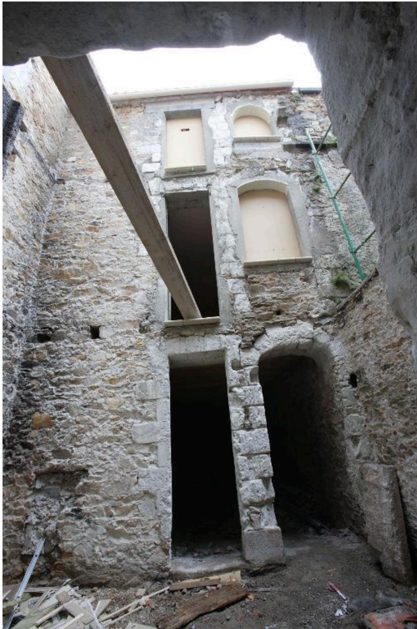
Maison n° 12 : la façade antérieure sur la cour du second bâtiment.
